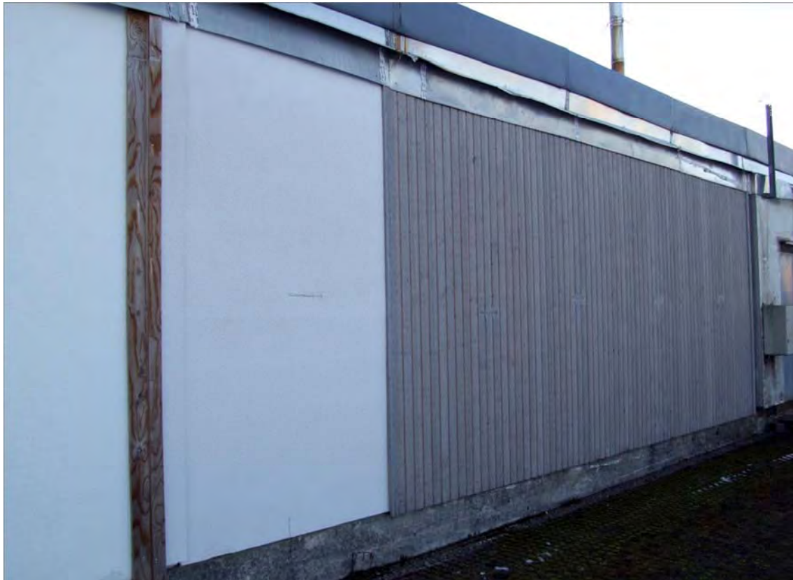
Abb. A-1: Stand der Aussenseite (Putz, Holzfassade) nach einem Jahr; gesamte Testfläche (oben), Frontansicht (unten)
